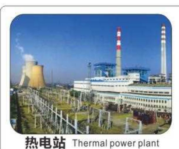
热电站 Thermal power plant
